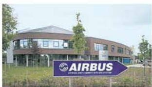
Das Technologiezentrum in Stade. Stadt und Land Niedersachsen stellten 8,1 Mio. € für das Gebäude zur Verfügung.
